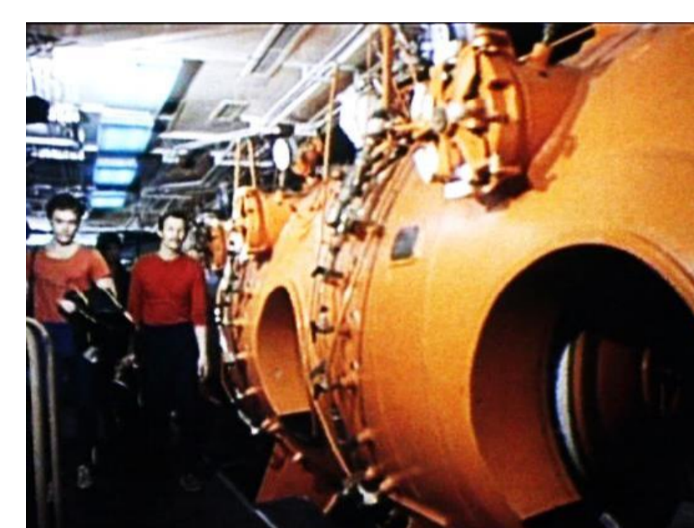
Глубоководный водолазный комплекс на НИС «ВИТЯЗЬ-4» Deep-sea diving complex for R/V «VITYAZ-4»
